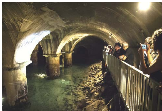
Les bassins filtrants de l'usine de Saint Clair, utilisés jusqu'en 1976
