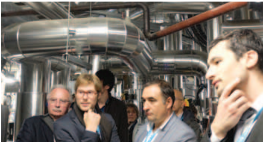
Dans les sous-sols du bâtiment Hikari, à la Confluence, les congressistes d'AMORCE découvrent les équipements produisant de la chaleur et du froid.
