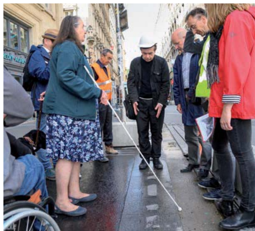
Visite de chantier de la place des Terreaux : test du dispositif créé à l'intention des personnes déficientes visuelles pour marquer la différence entre le trottoir et la chaussée.
