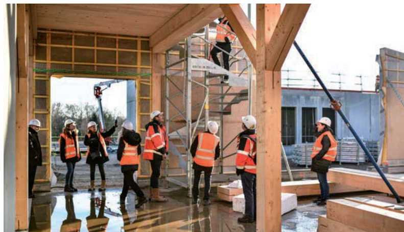
Chantier du collège dans le quartier de Revaision (Saint-Priest).
