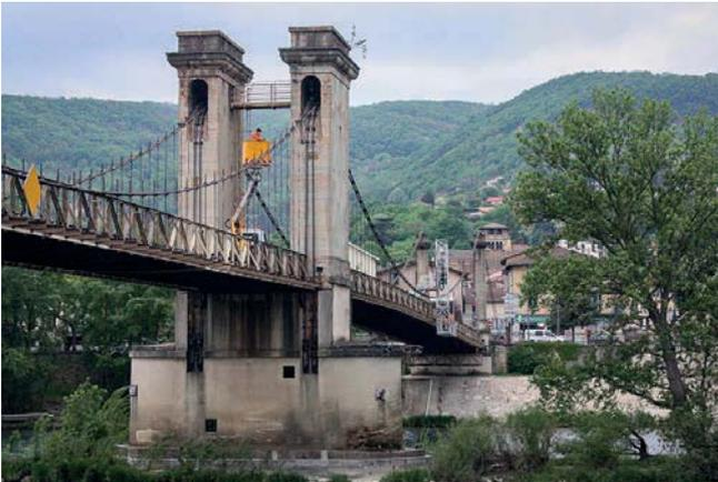
^ Pour faire une inspection générale de tout le pont, deux sortes de nacelles sont utilisées : une dite « positive » qui permet d'atteindre les éléments situés en hauteur (en jaune), et une dite « négative » (au second plan) pour pouvoir accéder aux pièces situées sous l'édifice.
