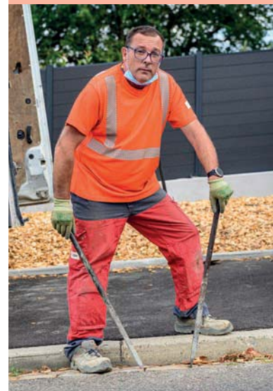
L'extraction des pavés à l'aide de deux barres de fer
