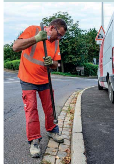
La barre à mine pour mettre les pavés en place
