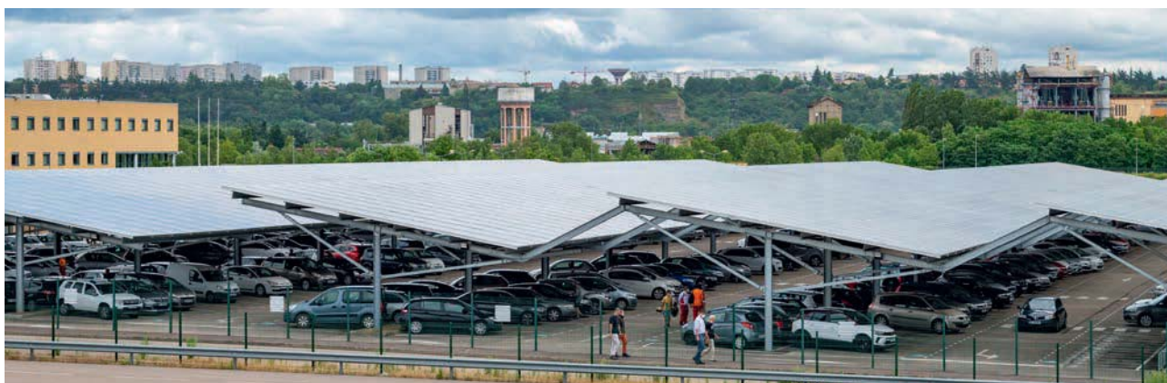
Ombrières de parking de la Vallée de la Chimie
