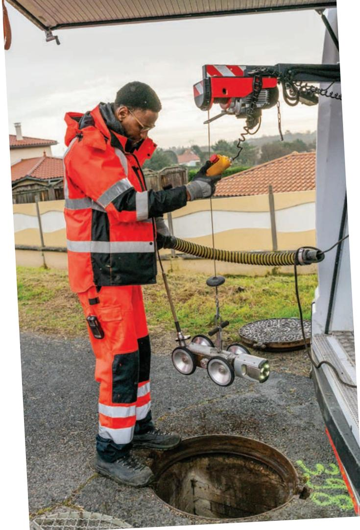
Keith Javois fait descendre la caméra dans l'égout, à l'aide d'un câble de 300 mètres de long.
